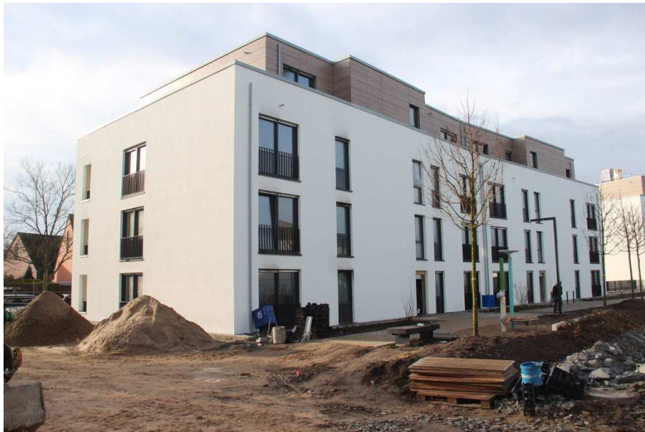
Abbildung 2 - Gebäuderückseite der im Bauzustand befindlichen Gebäude mit Eingängen
