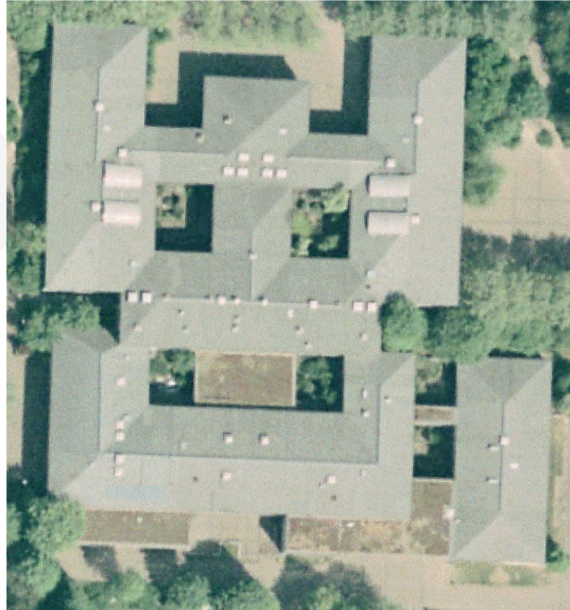
Luftbild 2007 Walmdach ca. 15° Neigung
