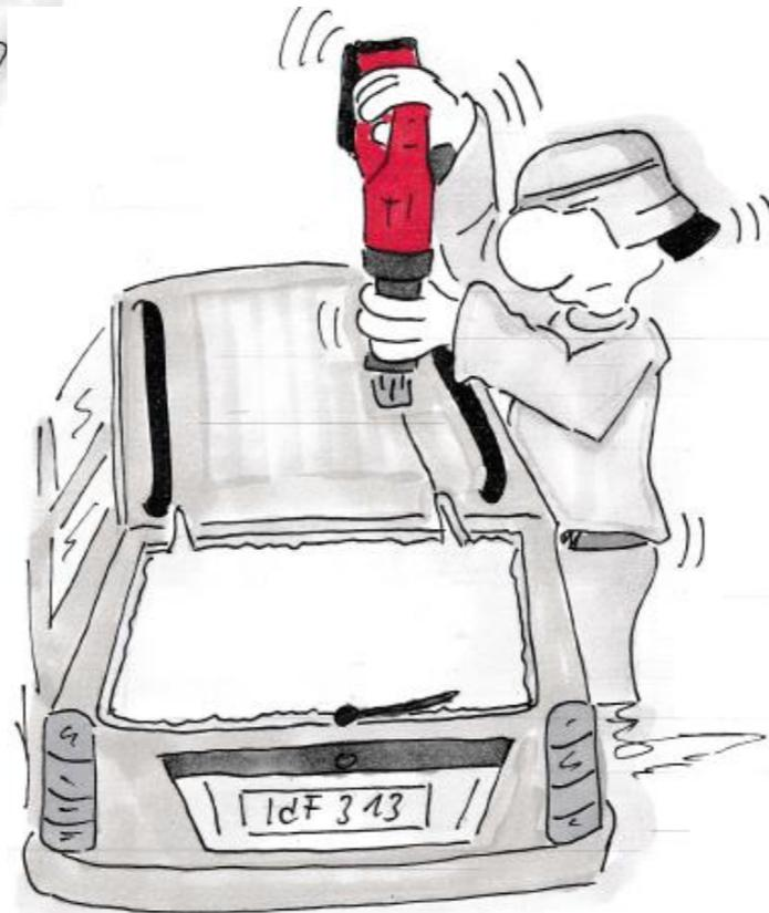
Mit der Säbelsäge das Dachblech aufschneiden. Säbelsäge dabei kräftig andrücken.
