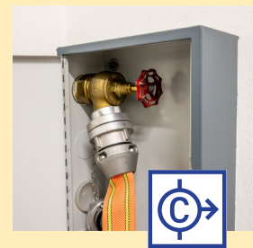
Entnahmestelle: DIN-Sechskant-Öffnung z.B. mit Feuerwehrbeil, Hydrantenschlüssel Typ B, Minikupplungsschlüssel möglich
