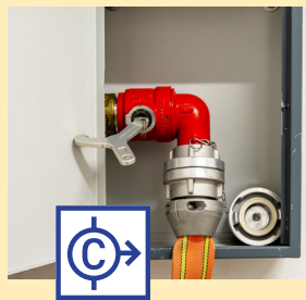
Entnahmestelle: DIN-Sechskant-Öffnung z.B. mit Feuerwehrbeil, Hydrantenschlüssel Typ B, Minikupplungsschlüssel möglich
