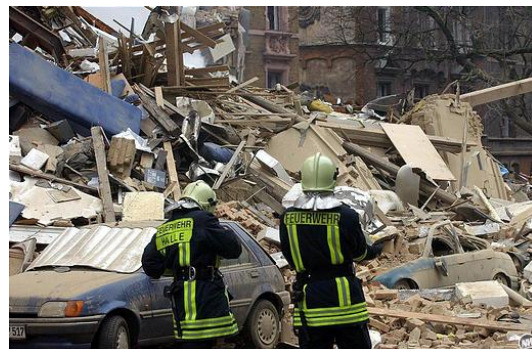
Bilder: Haus nach Gasexplosion, Schadensklasse 5
