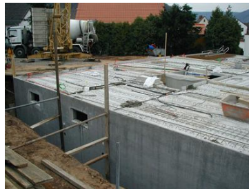
Bild: Gitterträgerdecke
