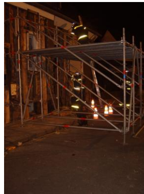
Bilder: Abstützen mittels Einsatzgerüstsystem
