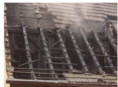
Bilder: Bilder nach Brand eines Wohnhauses der Schadensklasse 2
