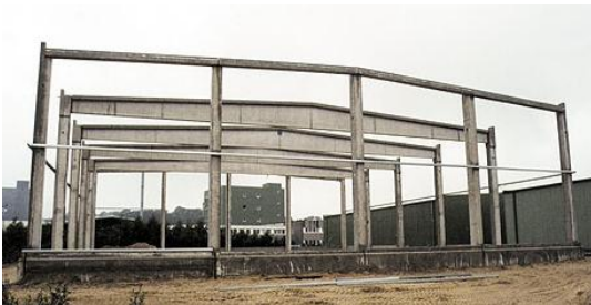
Bild: Stahlbetonfertigteilkonstruktion Fertigteiltreppenlauf
