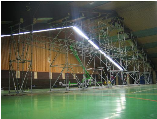
Bilder: Abstützen mittels Einsatzgerüstsystem
