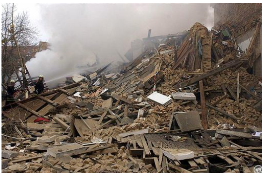
Bilder: Haus nach Gasexplosion, Schadensklasse 5
