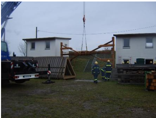
Bilder: Spreizwerk ca. 10m und Strebstütze 5m
