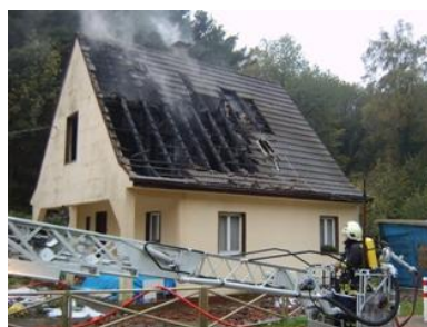
Bilder: Bilder nach Brand eines Wohnhauses der Schadensklasse 2
