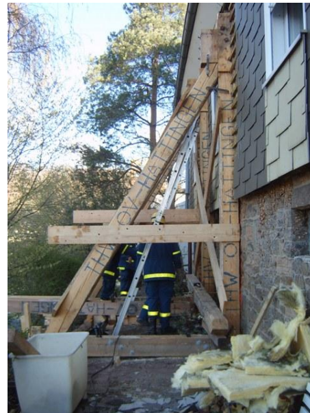
Bilder: Spreizwerk ca. 10m und Strebstütze 5m
