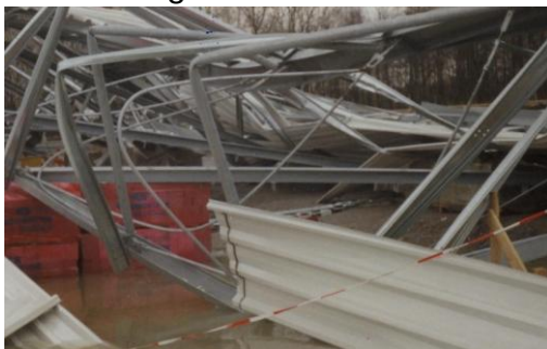
Bilder: Versagen einer Stahlhalle nach Verbandsausfall und Wind
