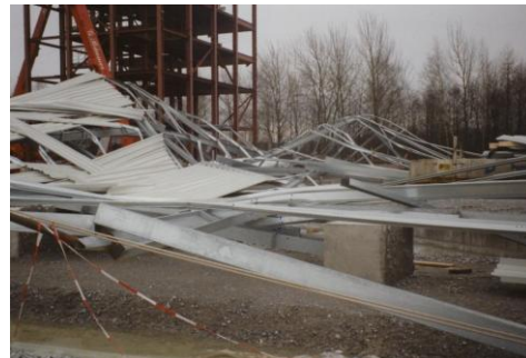
Bilder: Versagen einer Stahlhalle nach Verbandsausfall und Wind
