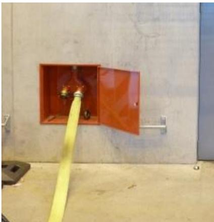
Steigleitungen ermöglichen eine Wasserentnahme an verschiedenen Punkten im Gebäude, ohne eine Schlauchleitung verlegen zu müssen. Somit können brandschutzrelevante Türen geschlossen bleiben und eine weitere Schadensausbreitung durch Rauch wird verhindert. Vor der Einspeisung sollten jedoch die Entnahmestellen durch die Feuerwehr kontrolliert werden, um ein unkontrolliertes Ausbreiten von Löschwasser im Gebäude zu vermeiden
