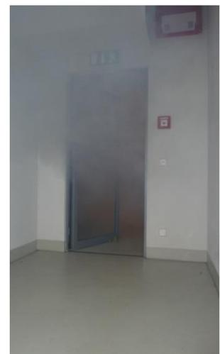
Abbildung 20: Rauchausbreitung durch Aufheben der Schutzfunktion [IdF NRW]
