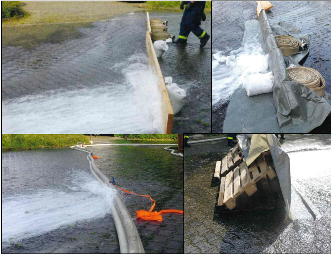
Abb 6-1: Improvisierte Wassersperren (Quelle: THW / R. Beyer)
