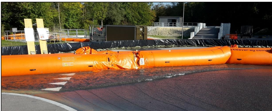
Abb 2-3: Einsatz von mobilen Wassersperren (Quelle: THW / V. Schauenburg)
