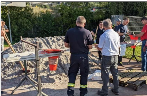
Abb 5-4: einfache Sandsackfüllstation (Quelle: Akademie Hochwasserschutz)
