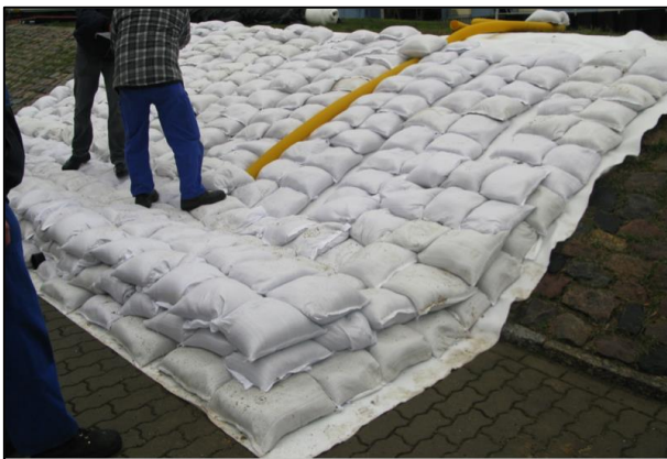
Abb 5-2: Auflast (Quelle: THW OV Emden)
