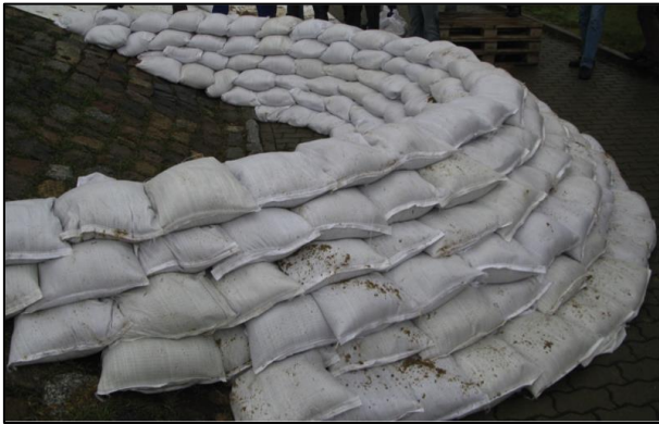
Abb 5-1: Quellkade (Quelle: THW OV Emden)
