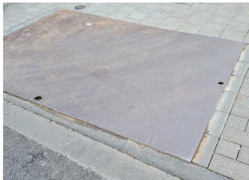
Abbildung 3: Stahlplatten als Abdeckung (eigene Aufnahme)
