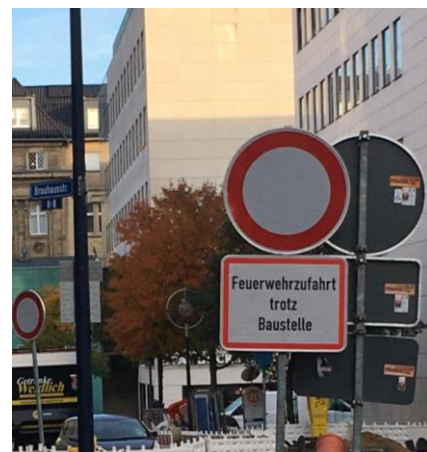
Abbildung 5: Kenntlichmachung von Feuerwehzufahrten in Baustellen (eigene Aufnahme)
