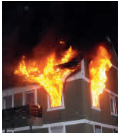
Abbildung 8 - alle Fenster sind flächig mit Flammen ausgefüllt, so dass der notwendige Sauerstoff von einer anderen Zuluftquelle kommen muss, Quelle: ecomed-Storck GmbH
