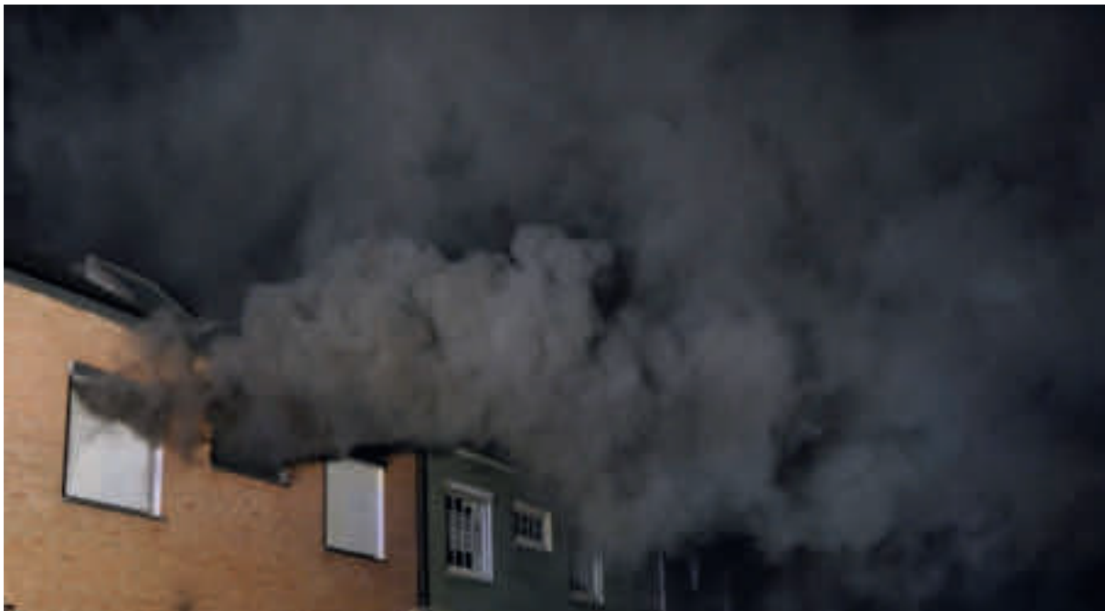
Abbildung 12 - Hier tritt ausschließlich Rauch aus der Abluftöffnung, aktuell ist ein Fensterimpuls noch nicht angezeigt, sollte jedoch in Bereitstellung gebracht werden, Quelle: Feuerwehr Hagen
