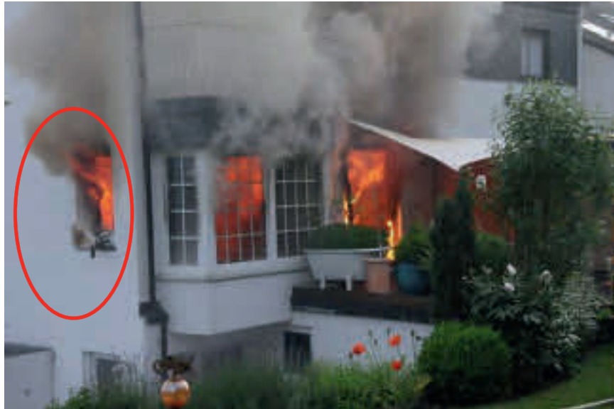
Abbildung 10 - Seitenfenster ist sowohl Abluft (oben - Flammen) als auch Zuluftöffnung (unten), Rossbach, Wuppertal, ecomed-Storck GmbH
