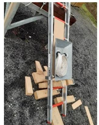
Bild 2 Fixierung der Schuttmulde mittels Unterbaumaterial
