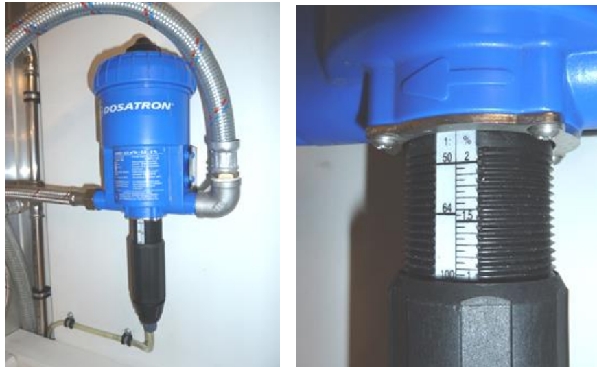
Abbildung 30 a, b: Dosiereinrichtung [IdF NRW]
