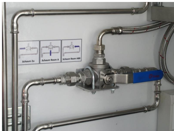
Abbildung 31: Ventil Raum C für Wasser und Dekontaminationsmittel [IdF NRW]
