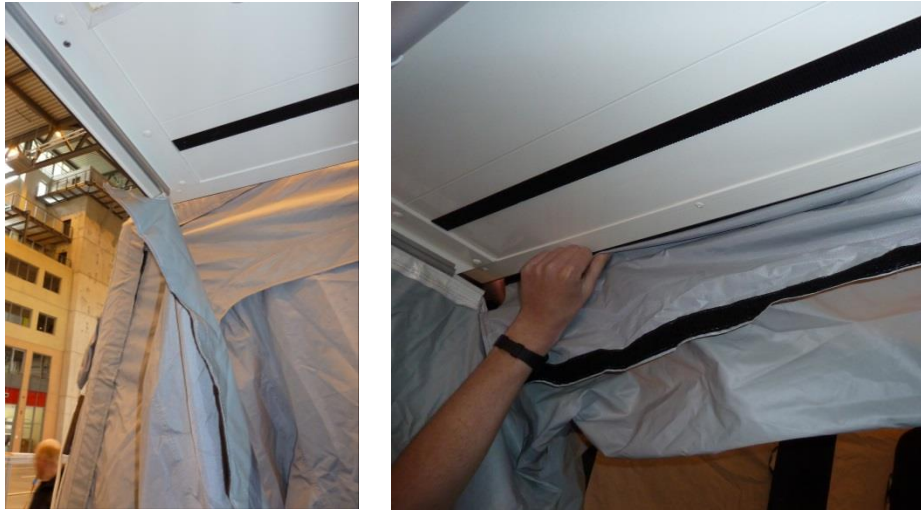
Abbildung 23 a, b: Zelte einführen und befestigen [IdF NRW]
