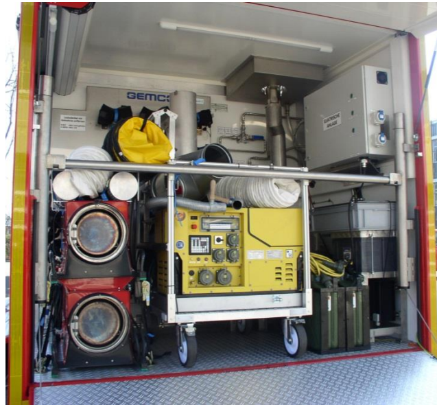
Abbildung 7: Ansicht hinten, Geräteraum C [IdF NRW]
